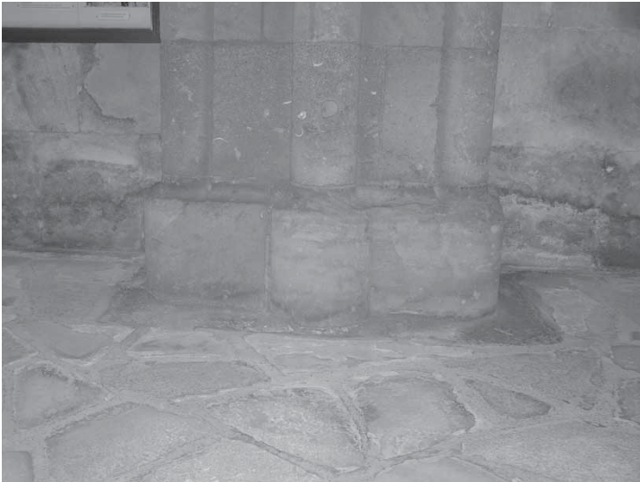
Fig. 45: Limassol Castle, réduit , detail of wall respond bases [M. Olympios].
